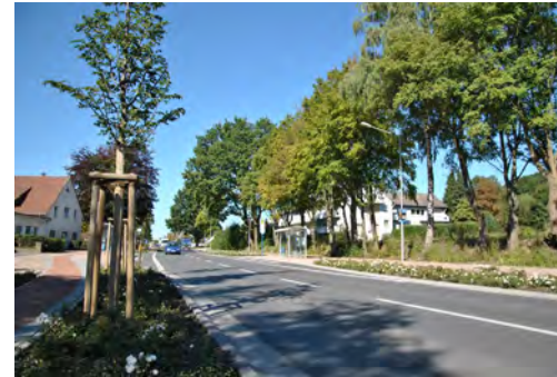
2015 Nebenanlagen Bündler Straße (L 545) OD Lippinghausen, Eilshausen und Sundern Gemeinde Hiddenhausen LP 1 - 9
