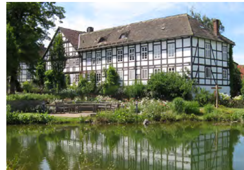
2003 Ortskernsanierung Ottenstein Ottenstein LP 1 - 3
