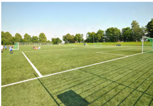
2010 Kunstrasenplatz Oetinghausen Hiddenhausen-Oetinghausen LP 1 - 9
